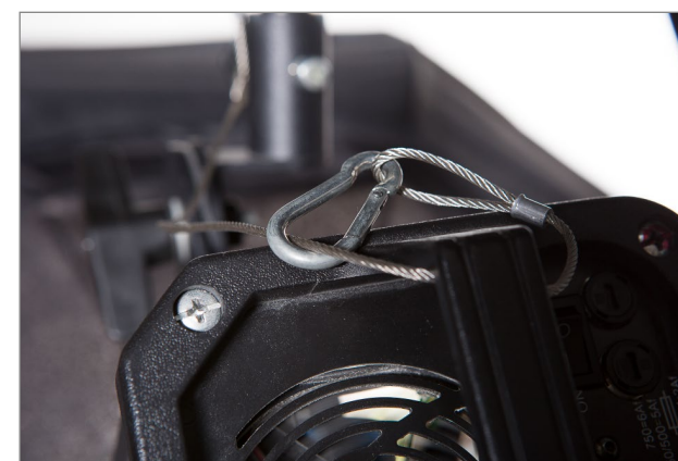
Sicherungsseil bei einem Deckenschienensystem
