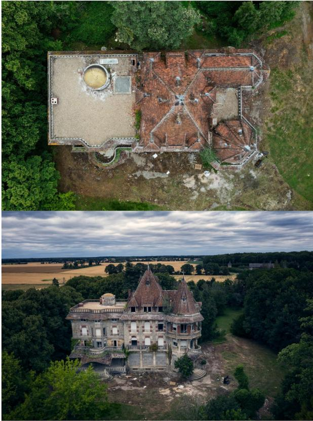
Oben: Beispiel für eine Satellitenaufnahme. Von oben kann man die Löcher im Dach gut erkennen. Die Vegetation auf dem Dach und die Trümmerteile rund um das Gebäude sind ebenfalls sichere Indizien für den Verfall dieses Herrenhauses. Unten: Das gleiche Gebäude vor Ort.
